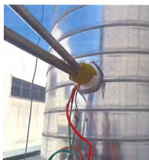
丝印及其后烘干工序废气排放口
