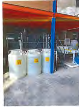
一般固废贮存间
