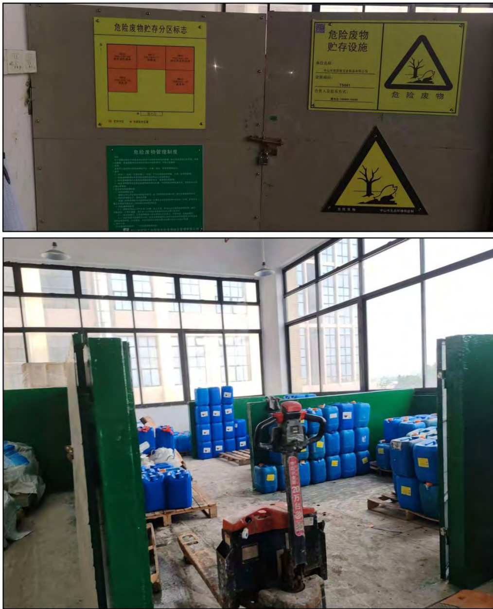
图 4.1-9 危险废物暂存间照片
