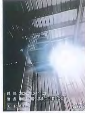
去油污工序、调漆、喷枪清洗、喷漆及其后晾干工 序废气排放口 G1 (处理后) (2026.03.04)
