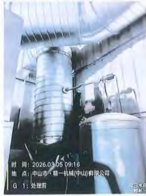
去油污工序、调漆、喷枪清洗、喷漆及其后晾干工 序废气排放口 G1 (处理前) (2026.03.05)
