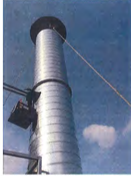
燃液化石油气废气、 退火工序废气排放口
